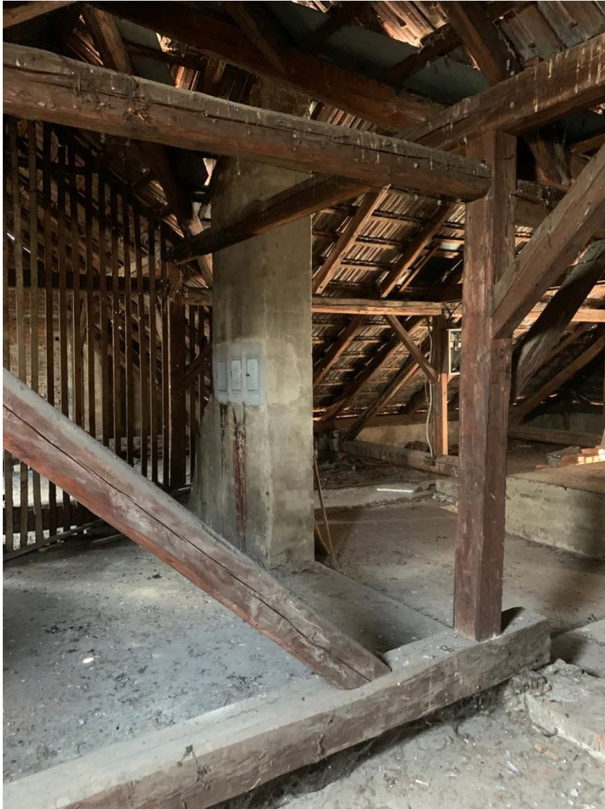
Fotografija 10 – Poktvljem s krovnom konstrukcijom- drvena građa
