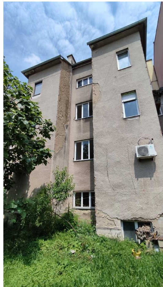
Fotografija 1 – Oštećenja vanjske žbuke s dvorišne strane
