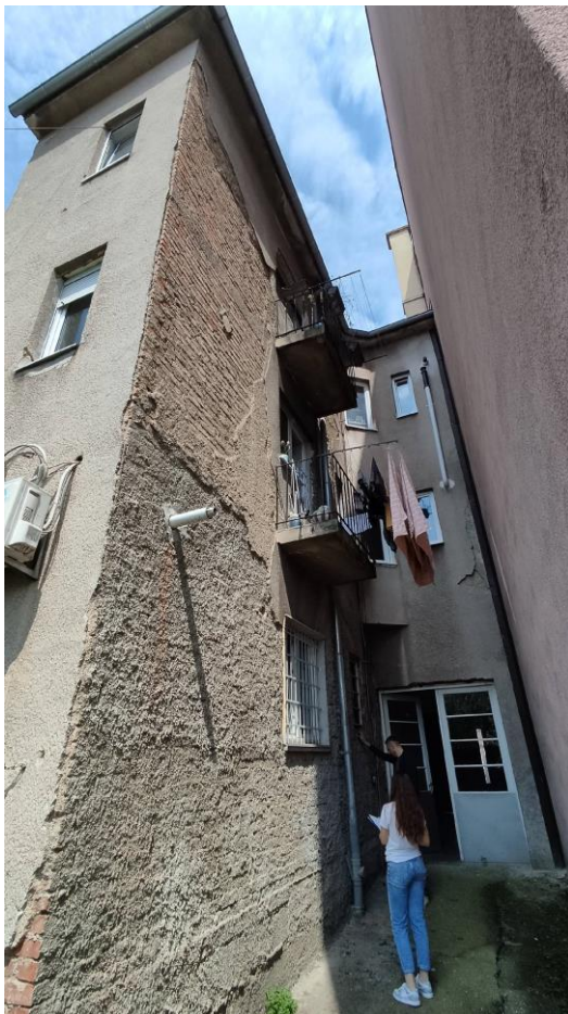
Fotografija 1 – Oštećenja vanjske žbuke s dvorišne strane
