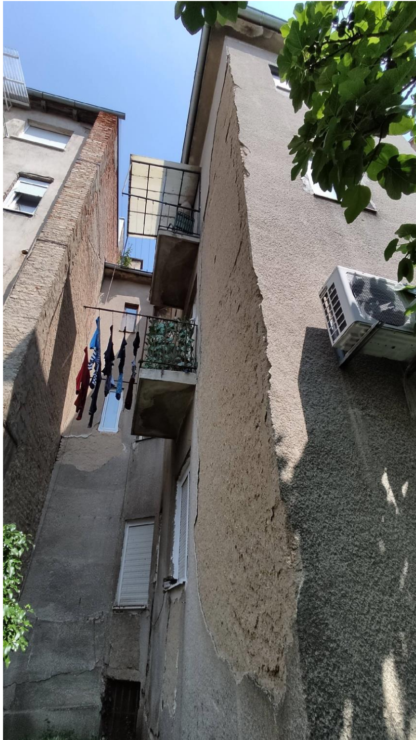
Fotografija 6 – Zapadni dio dvorišnog pročelja zgrade
